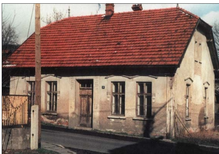
stavba pred rekonstrukciou
