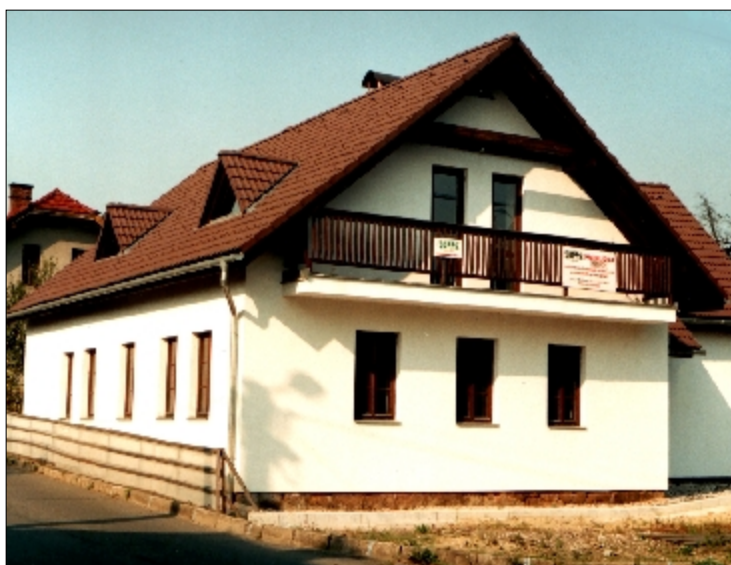
stavba po rekonstrukcii
